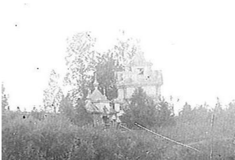
Фото 1926 г. церковь «Алексия Московского» построенная в 1905 г. и слева «Святые ворота», построенные в 1995г.
