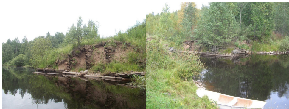
Фото 2015 г. Остатки плотины
