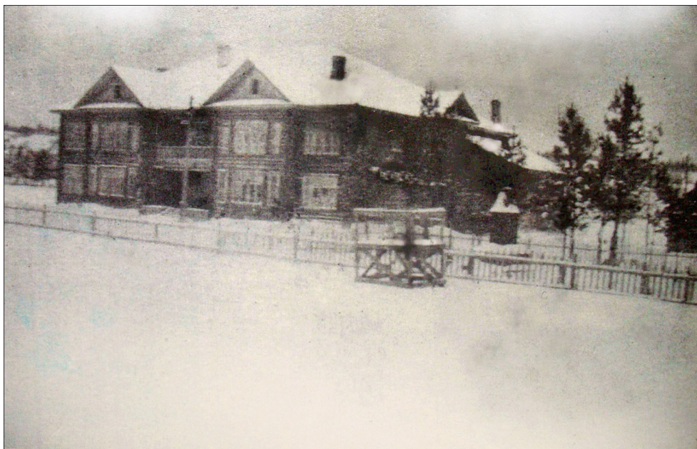
Фото 1949 г здание сгоревшего дома культуры, бывшей церкви Тихвинской иконы Божьей Матери
