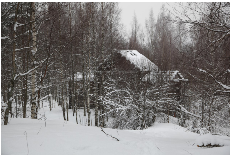
Фото 2017 гг. недостроенное и разрушающееся здание храма.
